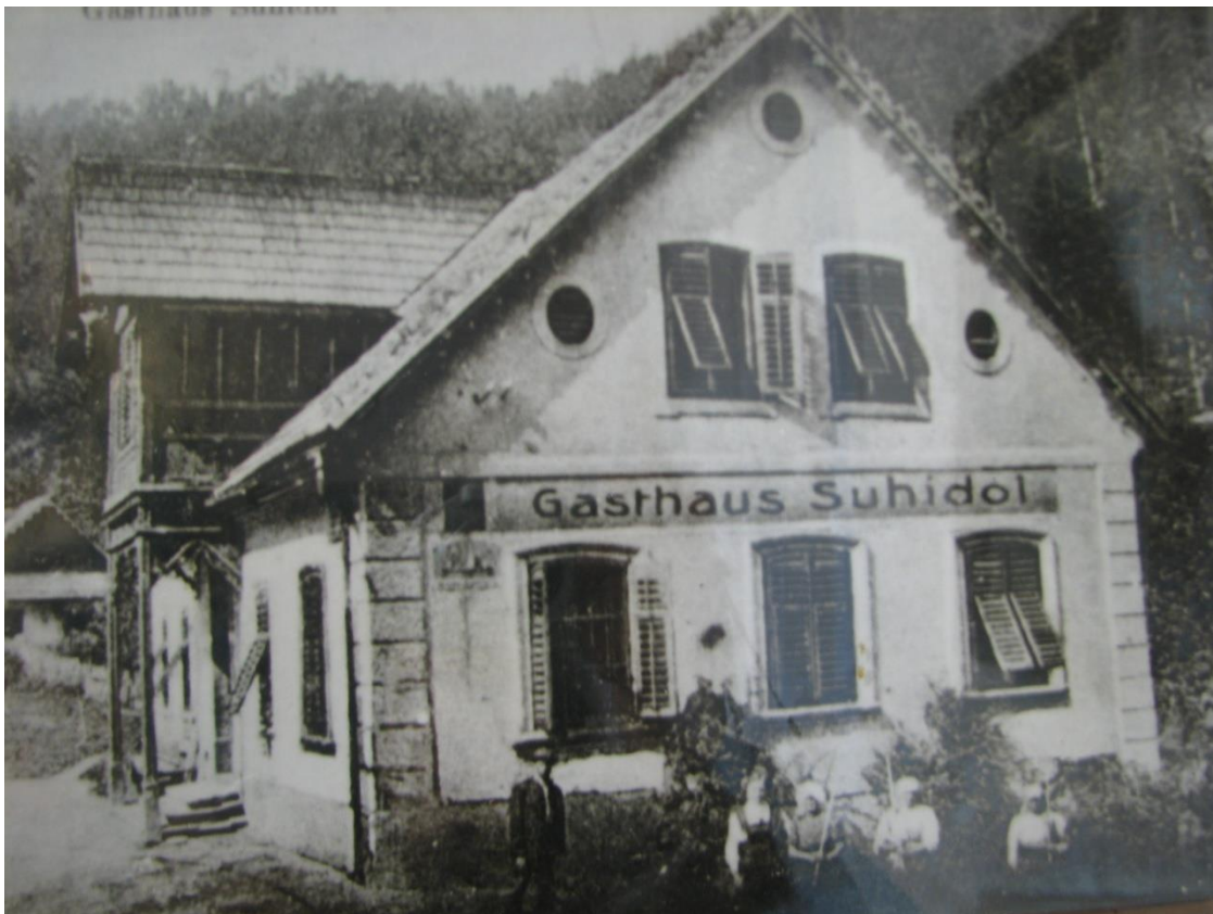
Slika 8: Gostilna Balek v Suhem dolu pred obnovo
