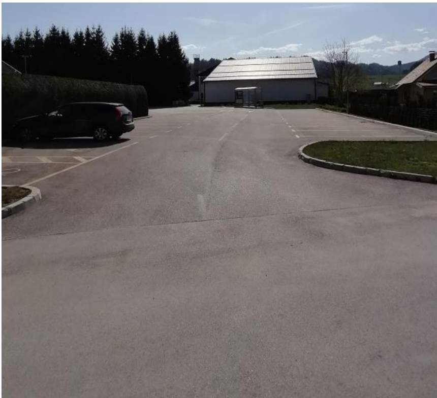
Urejeno parkirišče, avtobusno postajališče. Varna pot od avtobusnega postajališča do šole ob šolskem igrišču.
